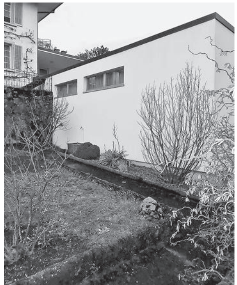
Hier an der Westseite kommt der Vorbau zu stehen
